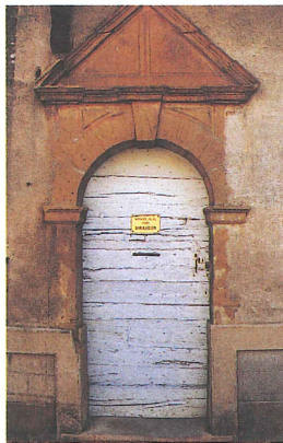
appareil irrégulier/assisé = enduit à pierres vues ou enduit couvrant
