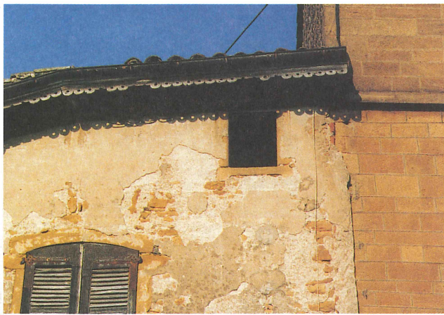
appareil régulier = restauration des joints
