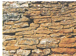
appareil non assisé = enduit couvrant
