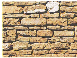
appareil irrégulier/assisé = enduit à pierres vues ou enduit couvrant
